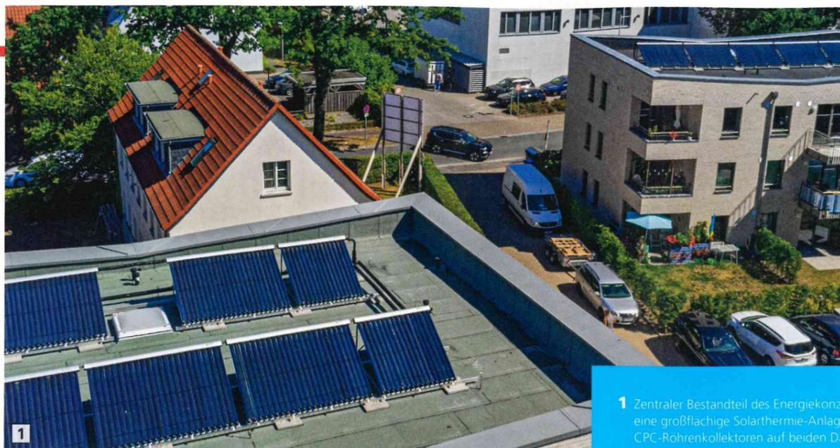
1 Zentraler Bestandteil des Energiekonzepts ist eine großflächige Solarthermie-Anlage mit CPC-Röhrenkollektoren auf beiden Dächern.
