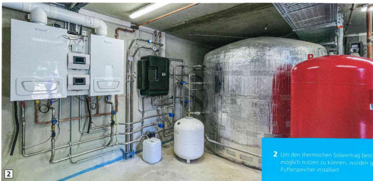
2 Um den thermischen Solarertrag bestmöglich nutzen zu können, wurden große Pufferspeicher installiert.
